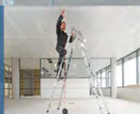
Przeniesienie punktu pionu montaż HVAC i instalacji elektrycznej
