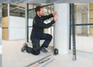
Wyrównanie pionowe z długim przerytym (prawie 360°) montaż płyt kartonowo-gipsowych
